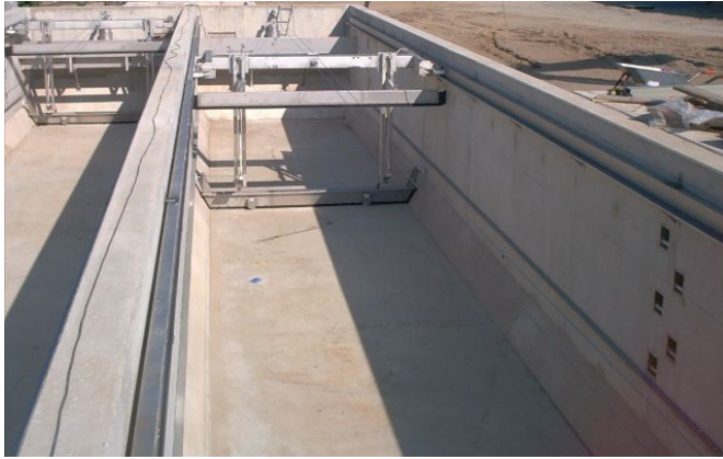
Seilzugräumer in einem Doppelbecken
