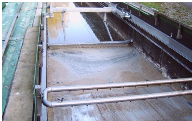
Schwimmstoffräumung mit einem Seilzugräumer
